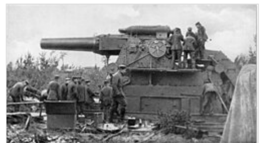
Ein schienengebundenes 42-cm- Bettungsgeschütz von Krupp („Dicke Bertha“) wird am 7. August 1914 bei Lüttich feuerbereit gemacht
