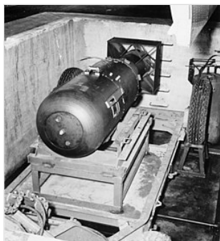
„Little Boy“ auf dem US-Stützpunkt Tinian vor der Verladung in den B-29-Bomber Enola Gay . Länge: 3,2 m, Durchmesser: 0,71 m, Uranmasse: 38,4 kg
